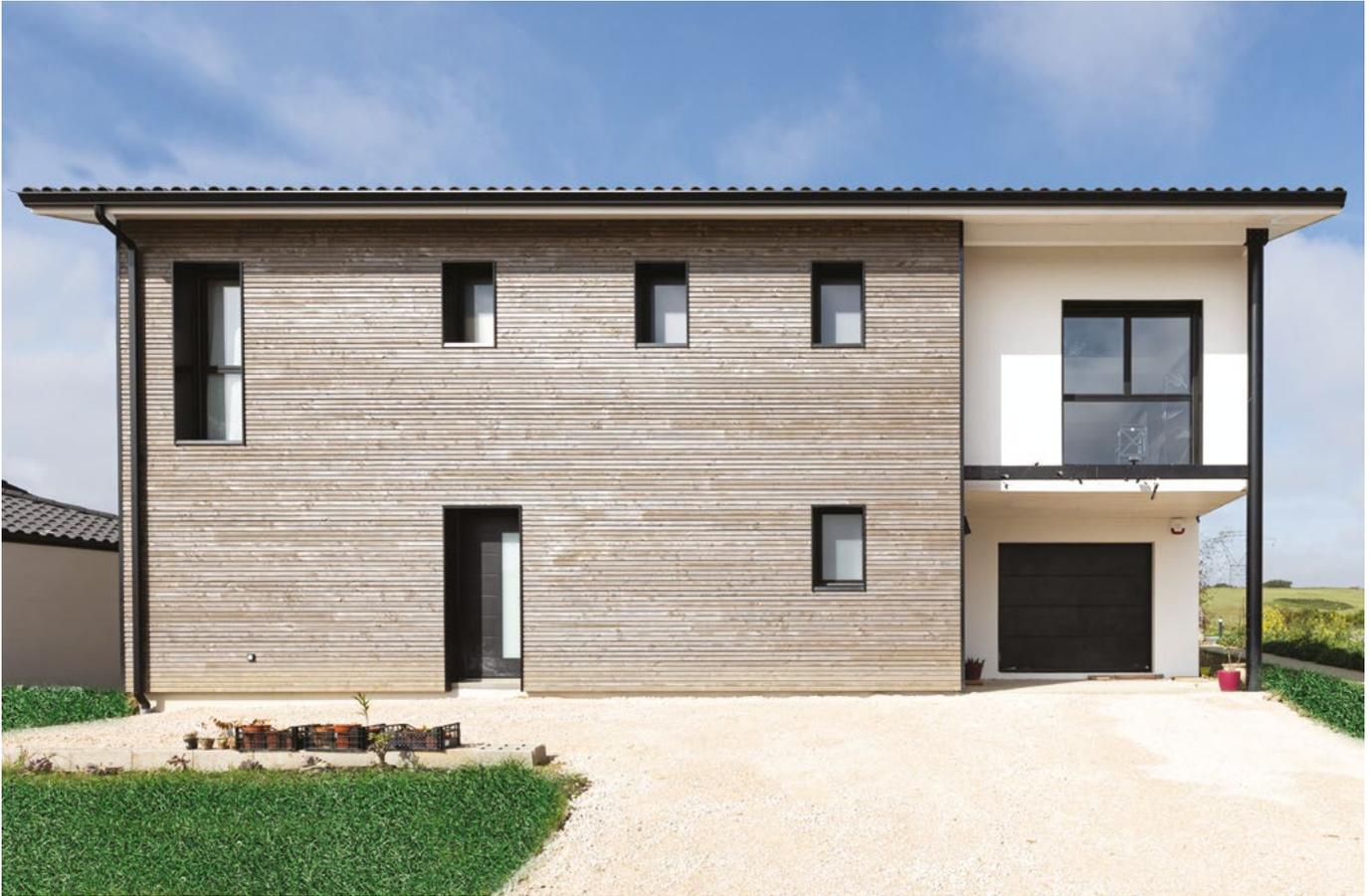
*Le bardage en douglas de la gamme New Age de [Sivalbp](#) a un aspect homogène gris contemporain qui évoluera dans le temps naturellement et très lentement dans les mêmes tons. Gouttières, menuiseries et poteaux sont noirs.*
