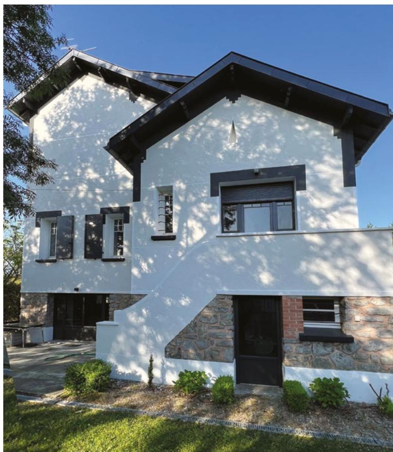
**Après les travaux.** Un calepinage séquence la façade. Il permet de casser la hauteur d'une part, et de faciliter une éventuelle reprise de façade en la réservant à la partie de la façade concernée.
