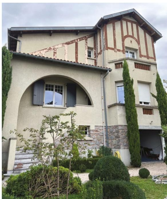
*Avant les travaux, les façades recouvertes d'un revêtement plastique épais, typique des années 1970, présentent des cloques et des fissures, et les colombages sont très abîmés.*
