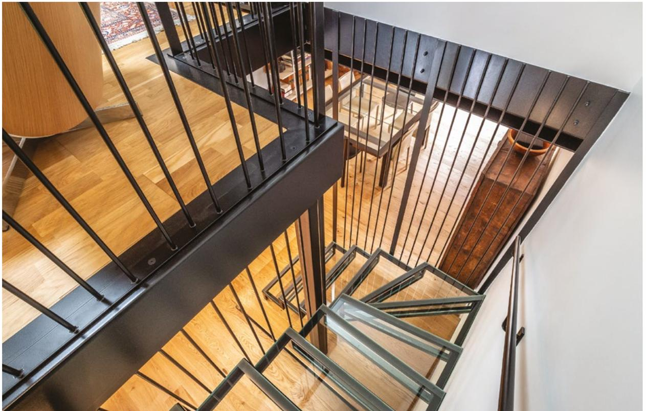
*Garde-corps en acier. Des tubes en acier soudés et peints sur place forment le garde-corps de l'escalier et de la mezzanine selon une composition rythmée.*
