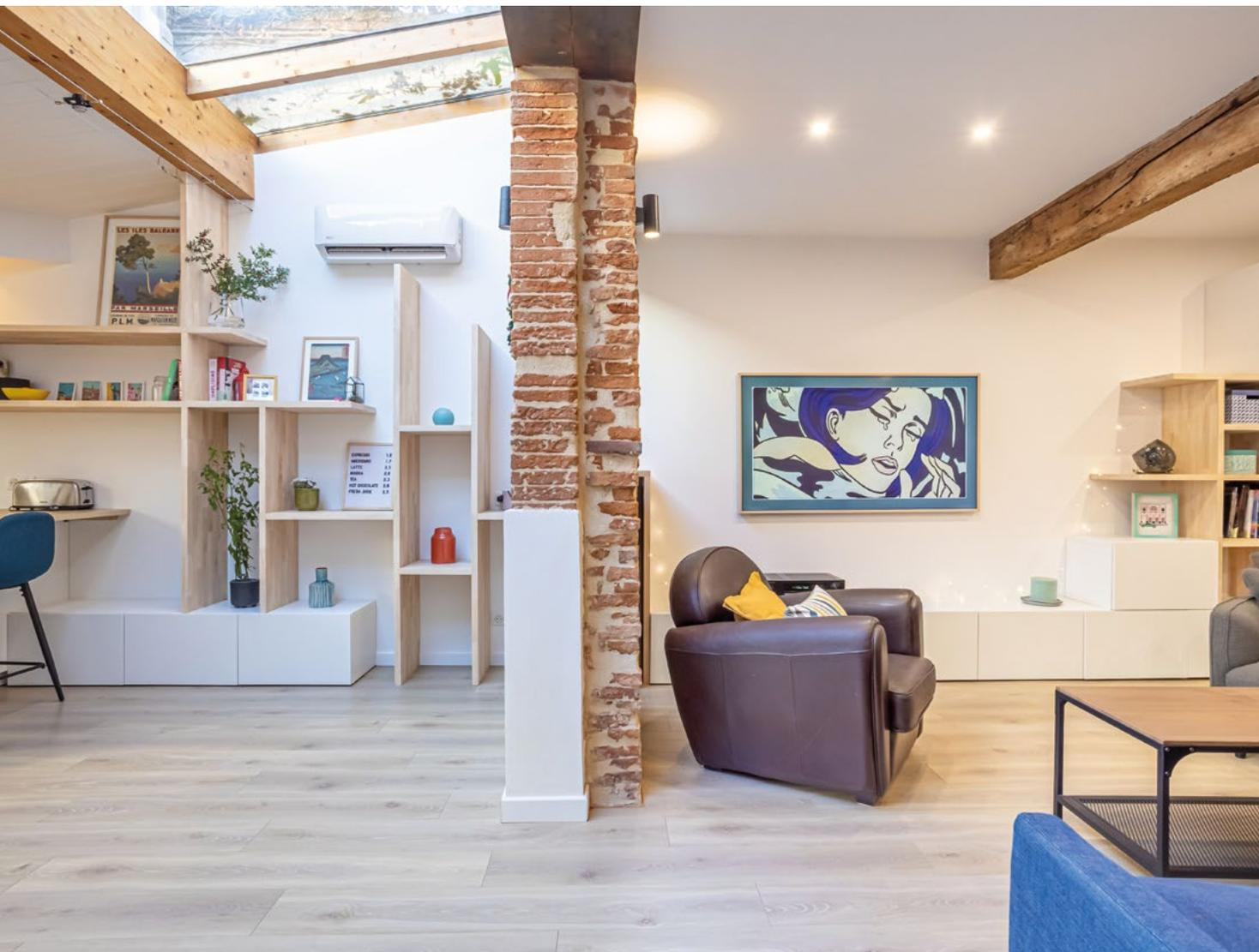
*Vue de coupe sur l'ancien mur porteur. Les piliers sont à présent reliés par un IPN. Les verrières au plafond sont remises à neuf pour une meilleure isolation. Un système de climatisation réversible est installé. Le meuble sur-mesure vient se confondre avec les éléments de la cuisine.*
