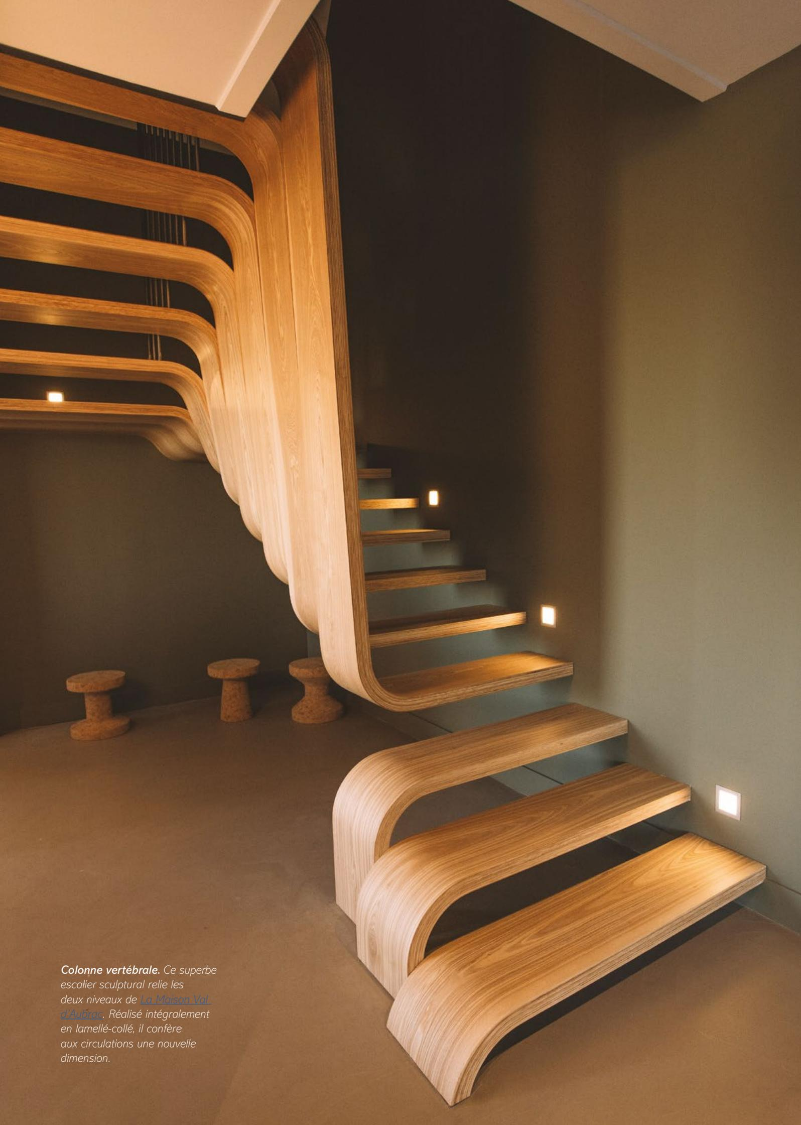
**Colonne vertébrale.** Ce superbe escalier sculptural relie les deux niveaux de [La Maison Val d'Aubrac](#). Réalisé intégralement en lamellé-collé, il confère aux circulations une nouvelle dimension.
