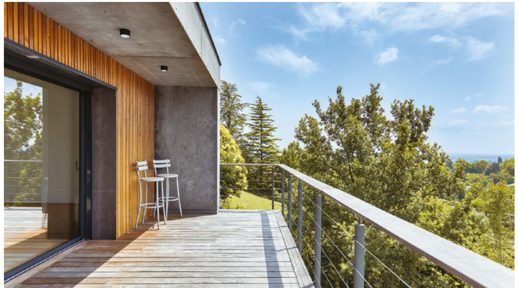
Les façades de la maison sont recouvertes de panneaux gris Viroc® et de douglas en pose à claire-voie (chez Cultur'Bois , Toulouse).
