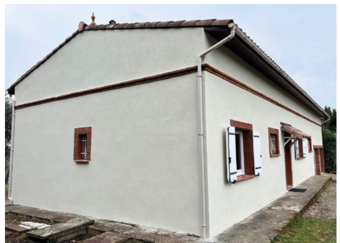
Après les travaux.
