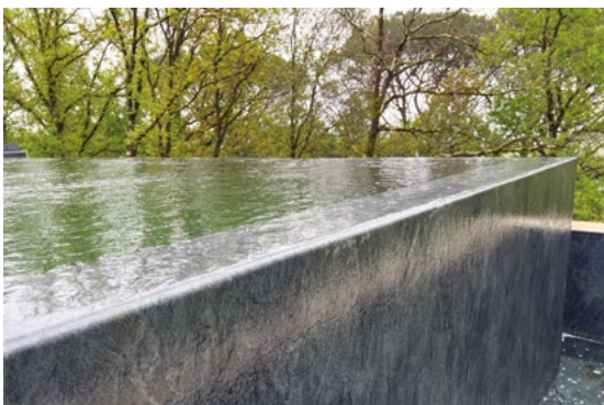
L'angle de la piscine où se trouve le débordement.
