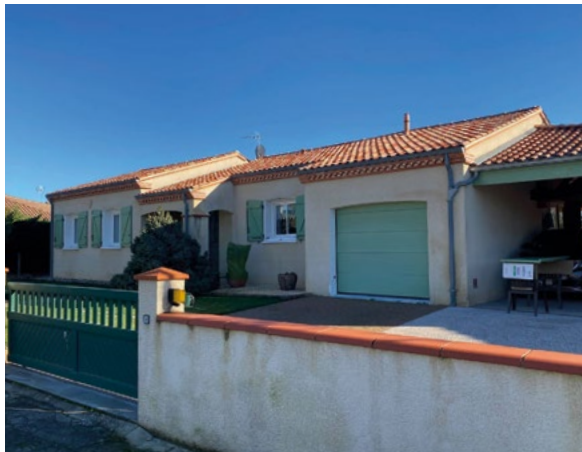
La maison côté rue avant travaux .
