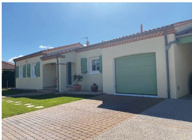
L'avant de la maison après travaux .
