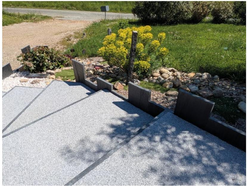
**Finition.** De la silice est ajoutée au mélange de résine Hydrostar pour un effet antidérapant.
