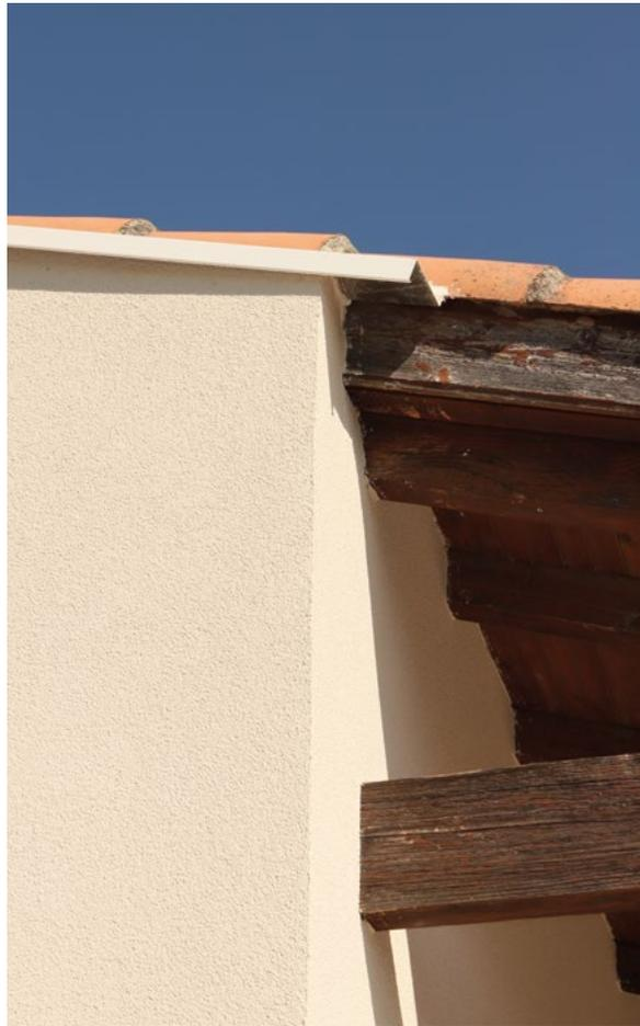
**Mur pignon.** L'isolation par l'extérieur en fibre de bois a induit une surépaisseur du mur pignon. En partie haute, elle a été recouverte d'une couvertine.
