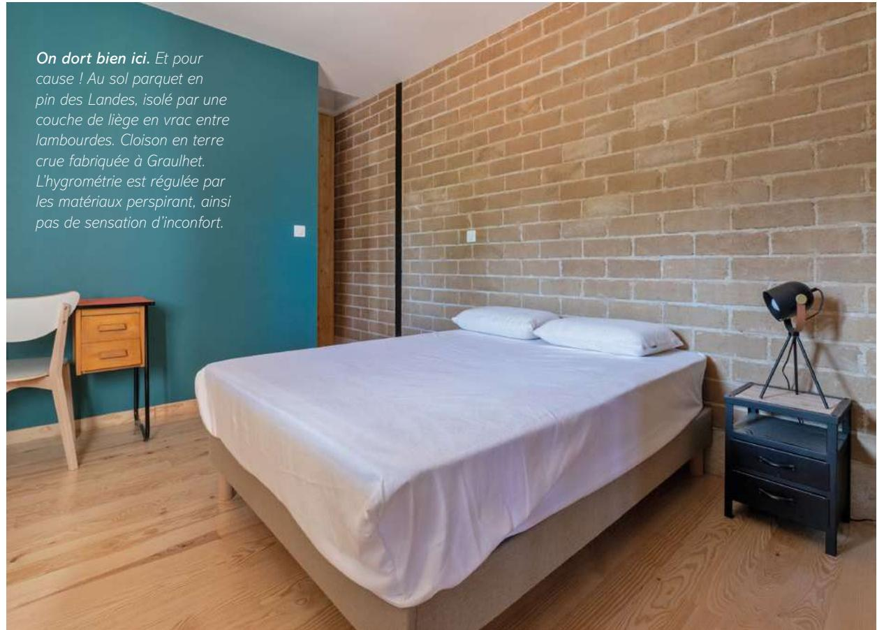
*On dort bien ici. Et pour cause ! Au sol parquet en pin des Landes, isolé par une couche de liège en vrac entre lambourdes. Cloison en terre crue fabriquée à Graulhet. L'hygrométrie est régulée par les matériaux perspirant, ainsi pas de sensation d'inconfort.*
