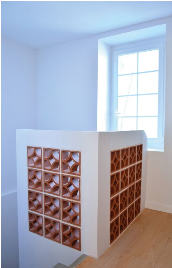
Escalier en béton fait par Azam Escaliers , et garde-corps en brique de Terres cuites d'Occitanie, dernière briqueterie du Tarn à encore faire sur place.
