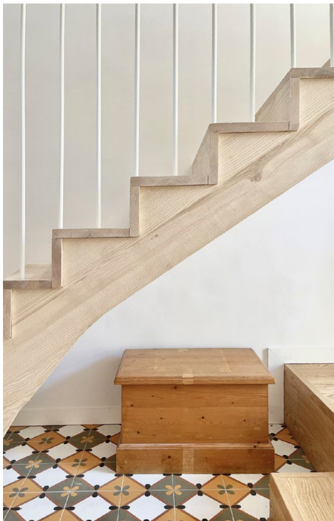
Dans la maison principale, l'escalier en hêtre réalisé par l'entreprise Maurel (Revel) mène aux trois chambres de l'étage avec salle de bains. On retrouve le motif de carreau de ciment présent dans la salle à manger. Seules ses couleurs ont changé.
