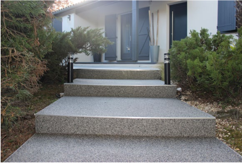
L'entrée de la maison a été traitée en moquette de pierre gris clair.
