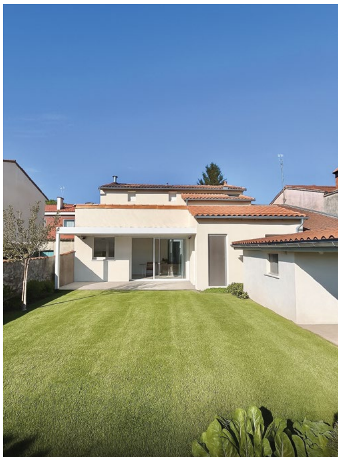
La salle à manger donne sur le jardin par une baie vitrée de 3,30 m de long en aluminium blanc. L'habitation est équipée de deux modes de chauffage : un plancher chauffant avec pompe à chaleur air/eau pour tout le rez-de-chaussée et un gainable sur pompe à chaleur air/air pour l'étage.
