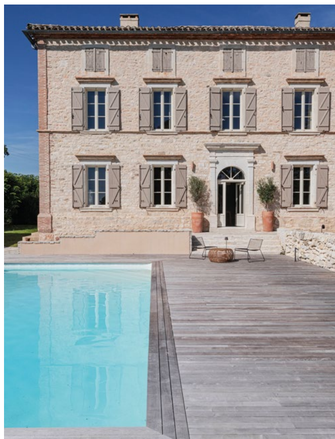
Retour aux sources. La façade en pierre locale de Puylagarde et blonde de Virac a retrouvé tout son prestige. Menuiseries et volets bois neufs.
