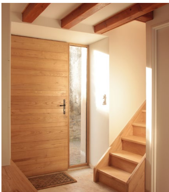
Chaleureuse entrée. Porte réalisée en châtaignier par le menuisier du village d'à côté. Escalier en frêne.
