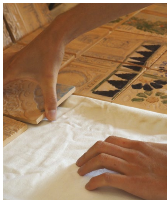
Moment chantier : l'étape laborieuse des 150 azulejos collés et jointés.
