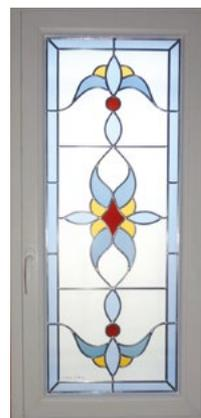
*Réalisation d'un vitrail en verre sablé pour cacher un vis-à-vis. Pose sur une fenêtre PVC et sur un double vitrage.*
